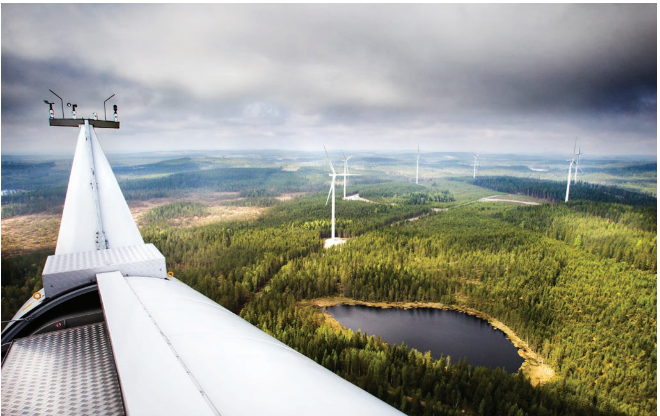
Fallåsbergets vindpark med tio vindkraftverk (23 MW) i Gävleborg, Sverige. Foto: Lina Westman.
