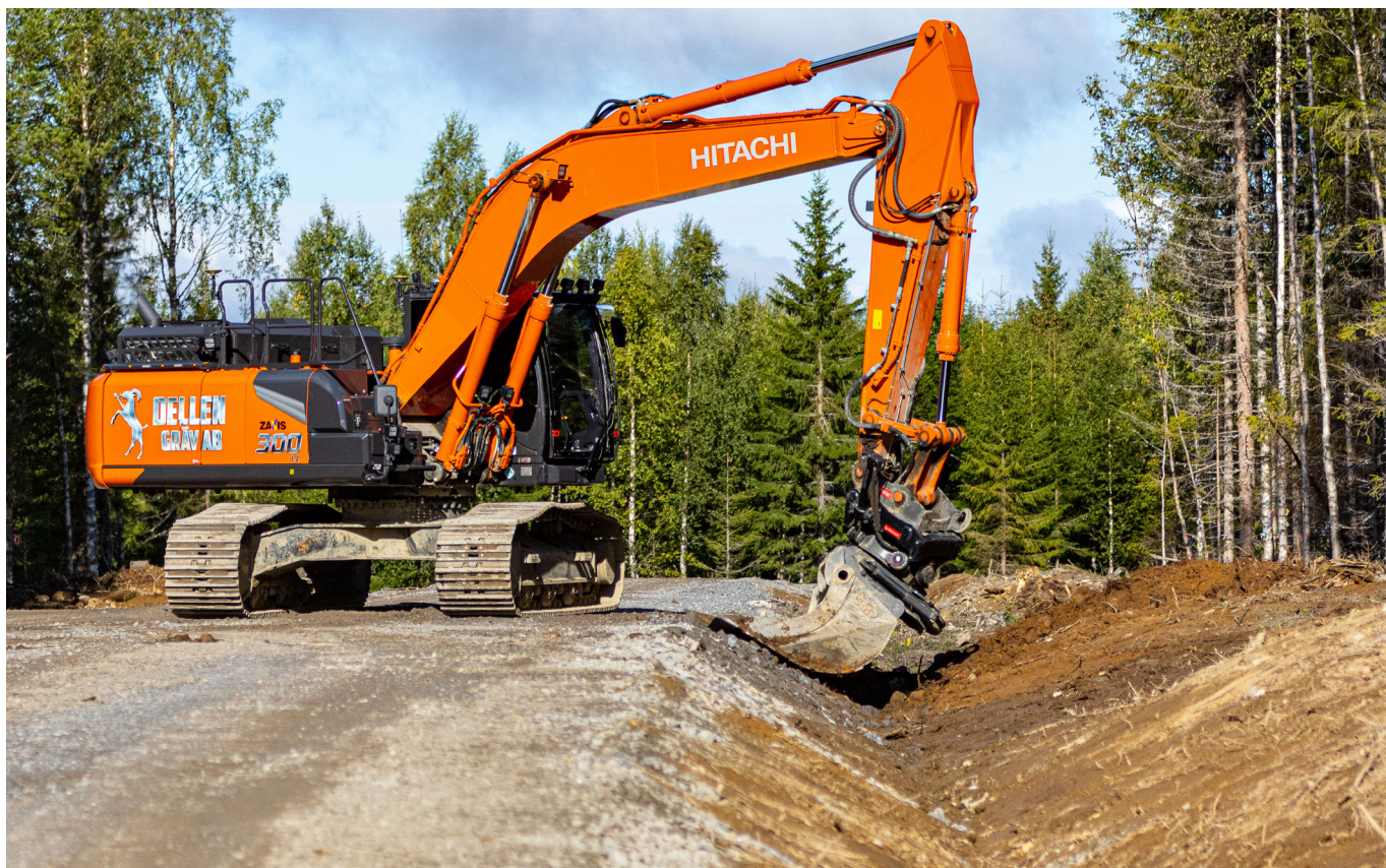
Figur 8. Exempel på nyanläggning av väg inom Klevberget vindpark i Ånge kommun (Foto: Henrik Hedman)
