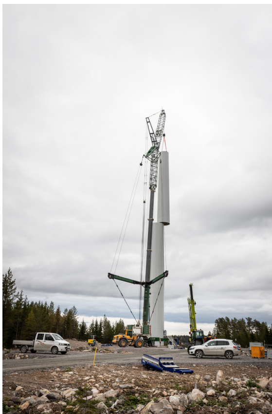
Figur 6. Resning av verk inom Vindpark Valhalla i Bollnäs- och Ockelbo kommun (Foto: Joakim Lagercrantz).
