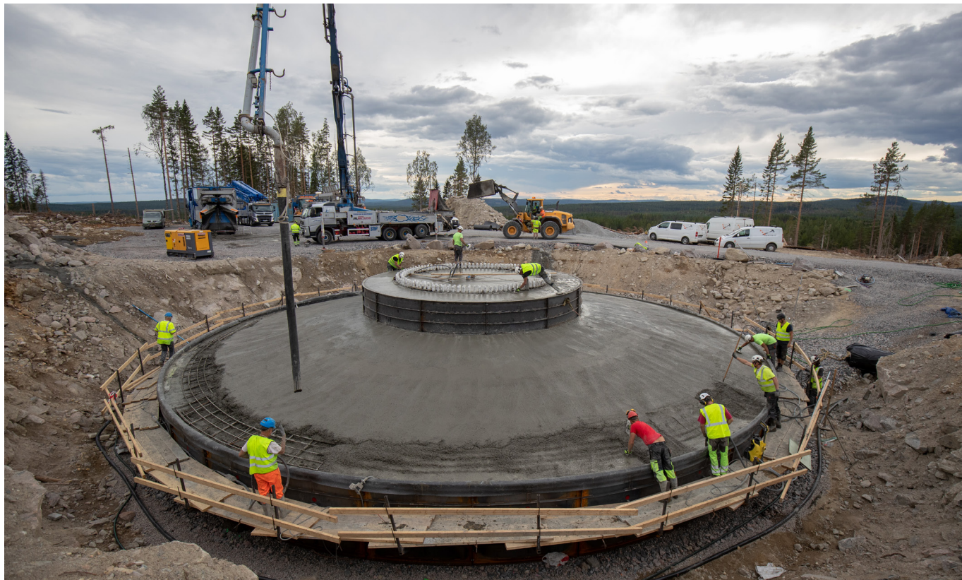
Figur 7. Gjutning av ett gravitationsfundament inom Vindpark Valhalla i Bollnäs- och Ockelbo kommun (Foto: Joakim Lagercrantz).
