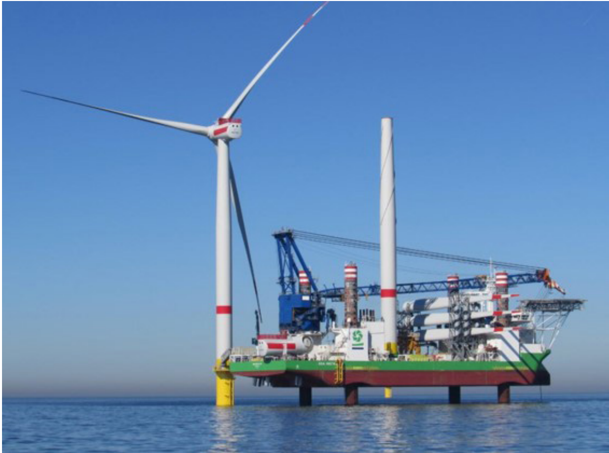
Figur 19. Montering av vindkraftverk med ett fartyg av typen stödbensplattform (jack-up). Källa: COWI.
